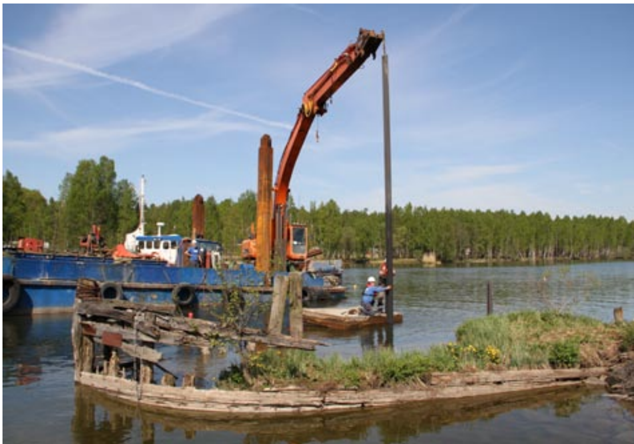
Spåntsättning i strandkanten. Lägg märke till resterna av den så kallade plattpråmen i förgrunden. Foto: Xray Film&tv.
