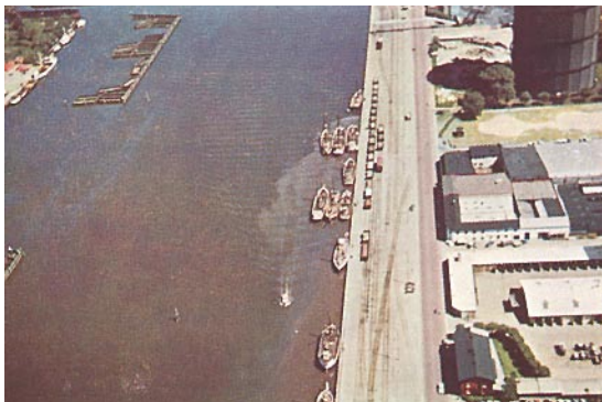
Utsläpp från pumpverket i Gullbergsvass.
